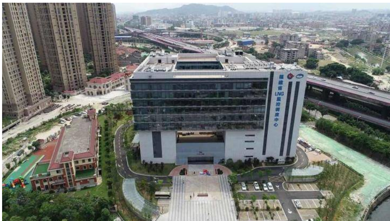
(福建LNG监控调度中心)
