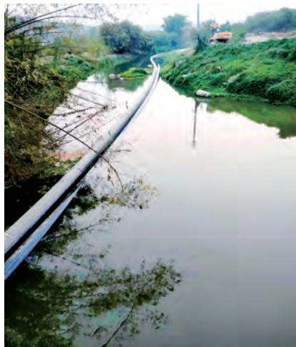
管涌和坍塌等。面对困难，项目部制定了详细的施工方案，优化扩孔工艺、泥浆配方，保障管道回拖降浮措施，最终顺利完成了回拖。
