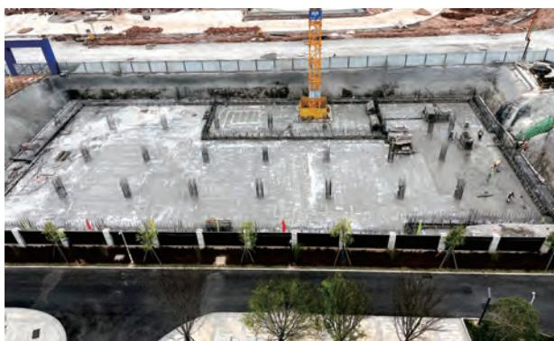
3月15日，随着最后一方混凝土从管道中喷涌而出，福州分公司承建的三明市中心血站技术业务用房建设项目顺利完成结构筏板基础混凝土浇筑，标志着三明市中心血站
